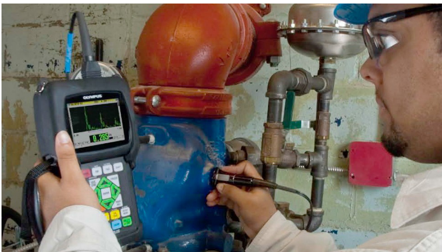
Figura 1-1 Medição de espessura com o 38DL PLUS
